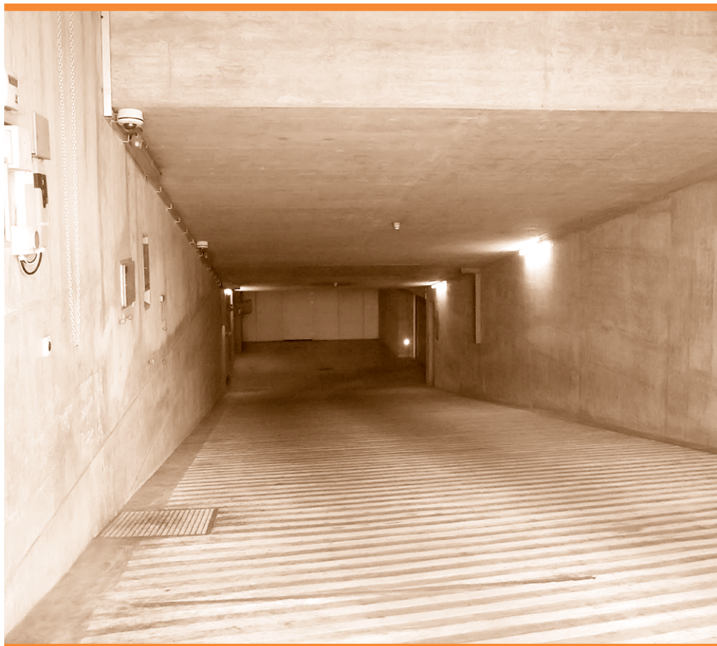
Eingang zur unterirdischen Unterkunft.
