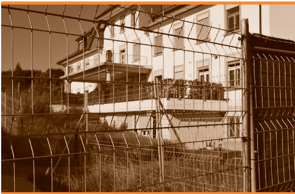
Perreux (NE). Ancien hôpital psychiatrique. Actuellement déjà utilisé comme complément du CEP de Vallorbe, futur centre fédéral de procédure.
